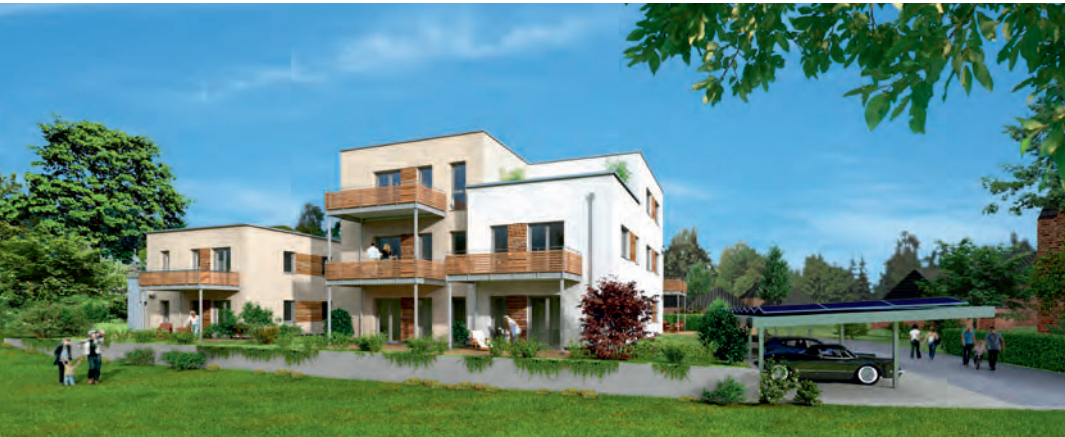
Oben: Wohnungsbau Teichstraße in Stade, Neustadtarchitekten, © Neustadtarchitekten
