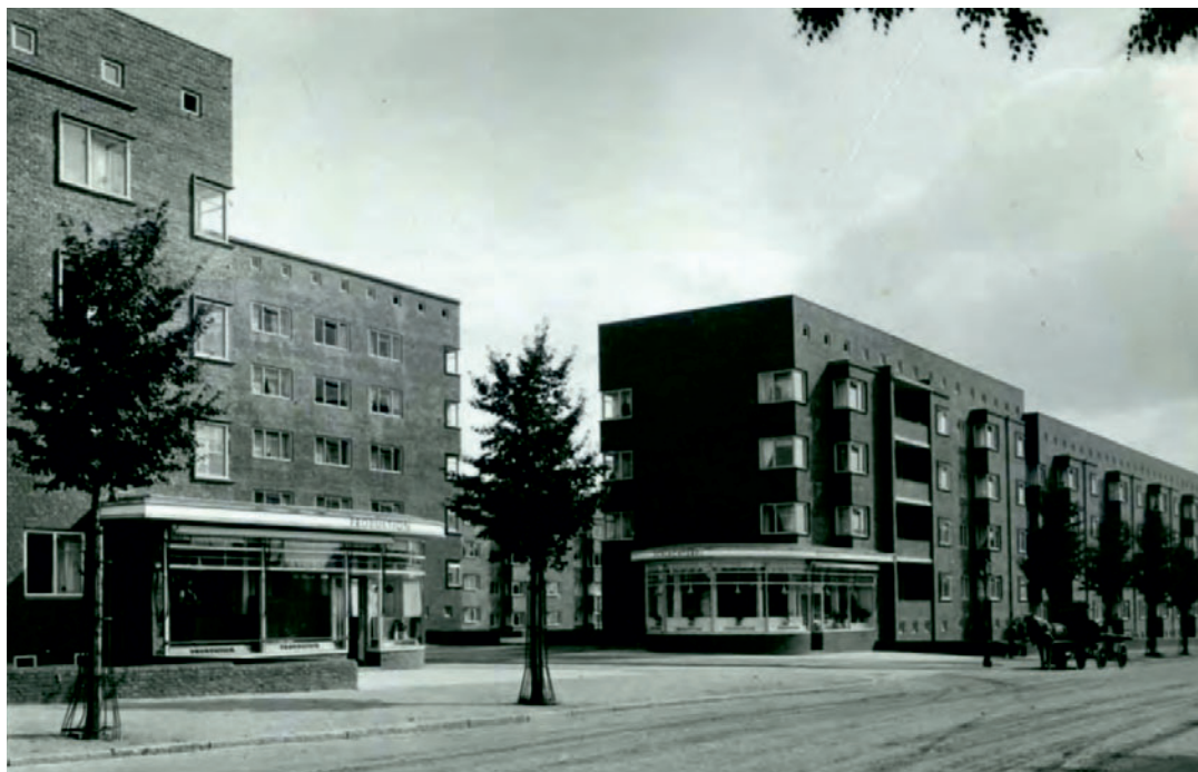
Wohnblöcke Habichtsplatz / Habichstraße in Hamburg-Barmbek (1926-28), Architekten: Karl Schneider mit Berg & Paasche. Foto: Dransfeld, Quelle: Hamburgisches Architekturarchiv
