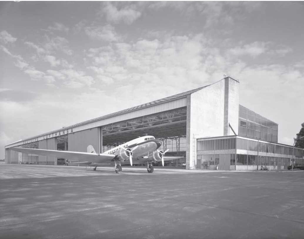
Die Halle 1/2 der Lufthansa Werft von 1955 besteht aus einer mit Klinkern ausgemauerten Stahlkonstruktion und besitzt große Fensterflächen und Schiebetore von fast 15 Metern Höhe. Ingenieur*innen: Carl Spaeter GmbH und Amt für Ingenieurwesen (Konrad Havemann).
