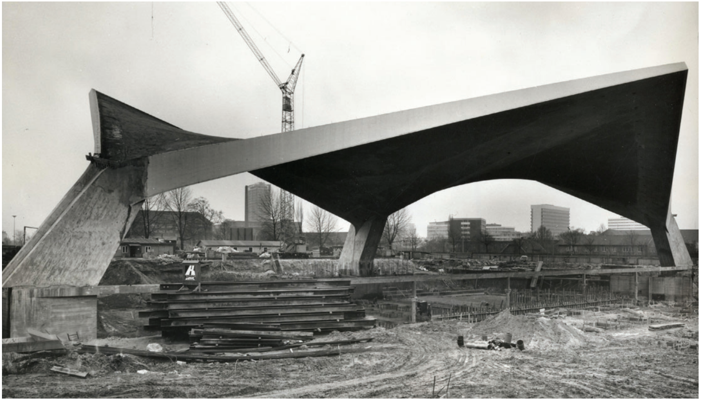
Die Alsterschwimmhalle (Foto: um 1969) besteht aus zwei gegeneinander versetzten Hyparschalen, die auf drei Pfeilern ruhen. Ingenieur*innen: Büro Leonhardt und Andrä. Architekten: Horst Niessen und Rolf Störmer, Walter Neuhäusser.
