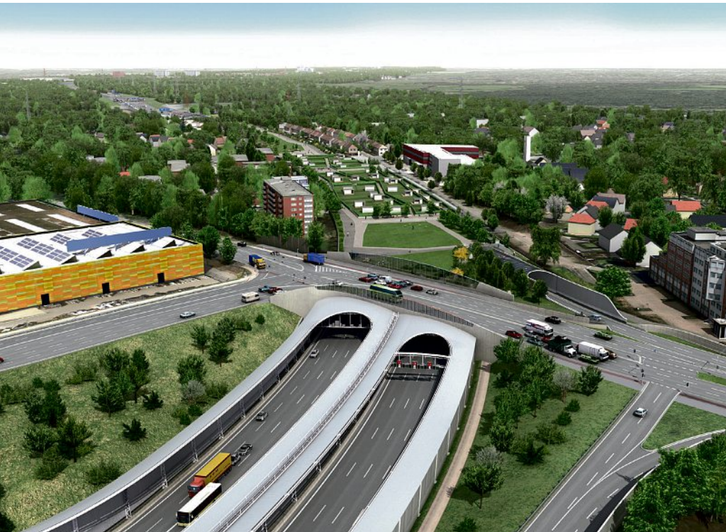
Tunnel Stellingen; Ingenieure: Schüßler Plan (Entwurfsplanung), Krebs & Kiefer und Hochtief Engineering (Ausführungsplanung), GBI und SSP (Betriebs- und Verkehrstechnik), EHS (Bauüberleitung, Bauüberwachung), DEGES (Projektsteuerung); Bild: © DEGES
